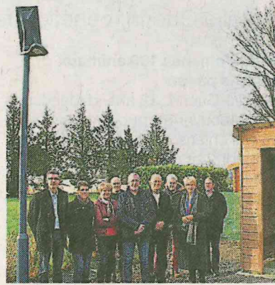
Élus bricquais, représentants du Sdem et de la Cégelec lors de la réception des travaux.
